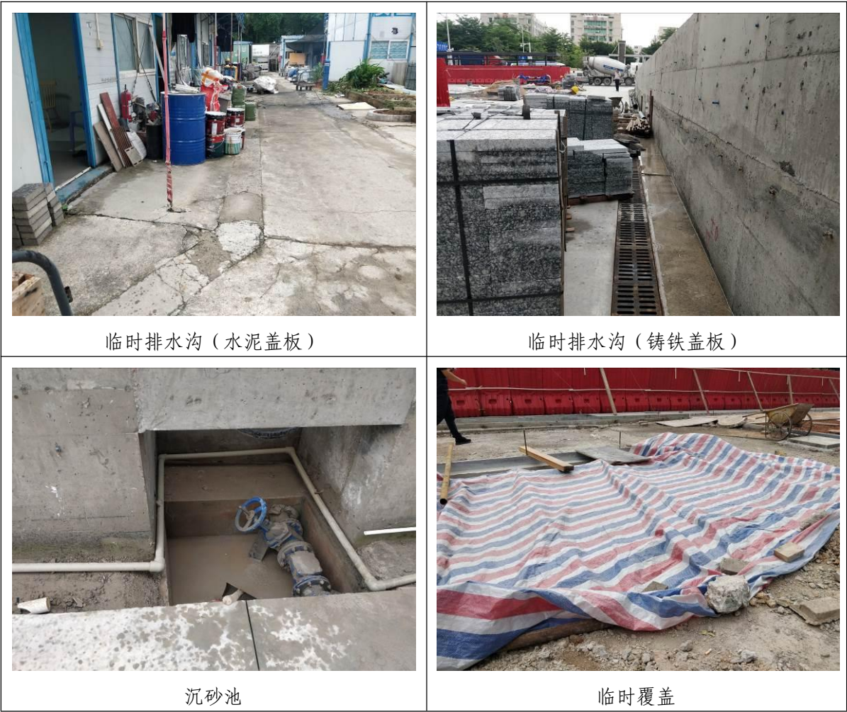
图4-4 临时措施施工期照片
