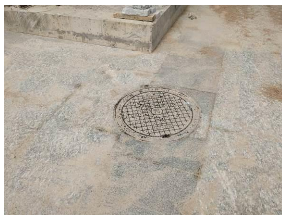
室外永久排水工程完工
