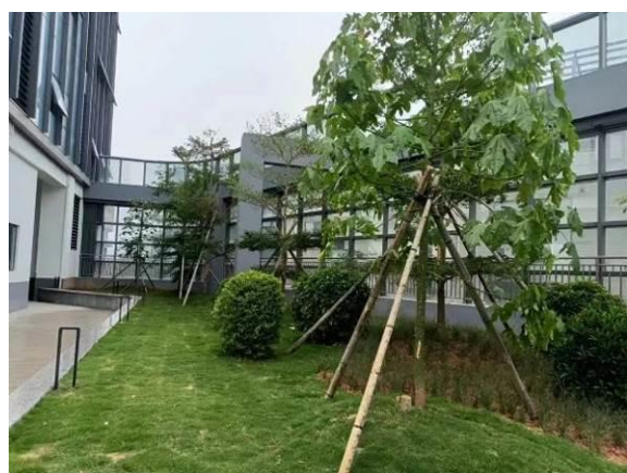
屋顶景观绿化完工
