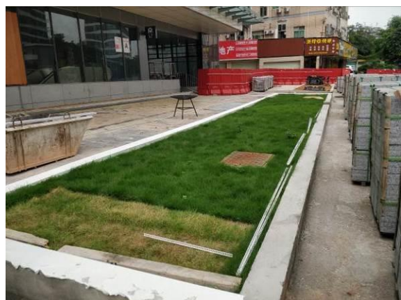
地面景观绿化完工
