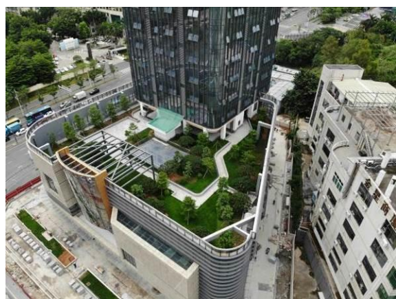
屋顶景观绿化完工
