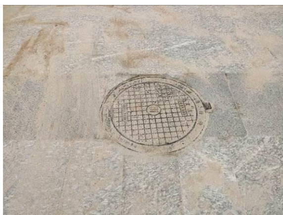
室外永久排水工程完工
