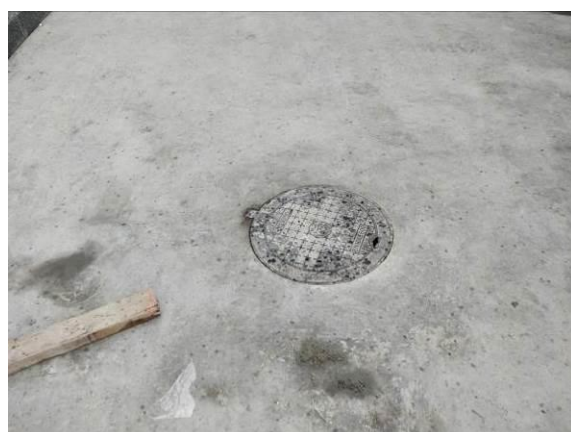
室外永久排水工程完工
