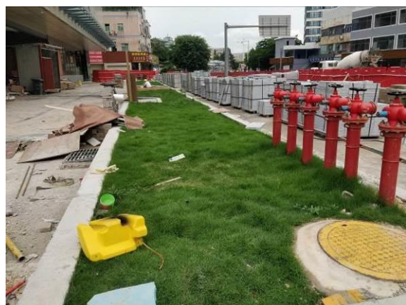
地面景观绿化完工
