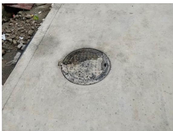
室外永久排水工程完工
