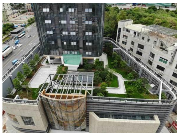
屋顶景观绿化完工
