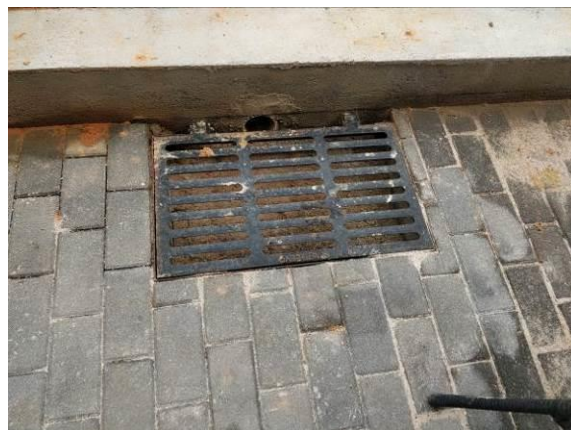
室外永久排水工程完工
