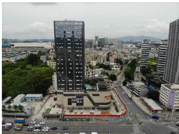
主体建筑物完工
